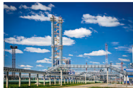
Омский завод полипропилена
