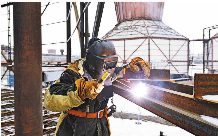
Идет сварка металлоконструкций
