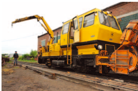
Ремонт железнодорожных путей
