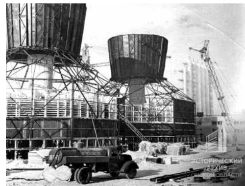
Сооружение градирен на строительстве завода СК.
