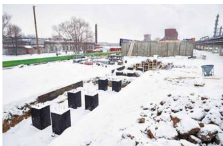
Строительство эстакады в Д-3-5
