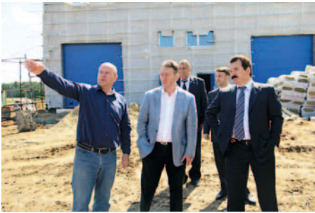
На площадке мясокомбината
