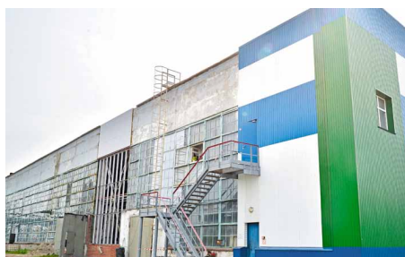
Ремонт в цехе ВС и ВО
