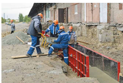
Работы на рампе
