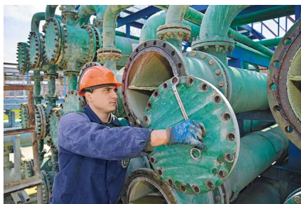
Ремонт аппарата в цехе Д-2
